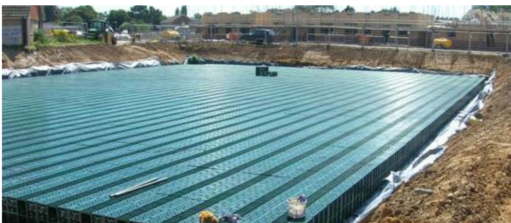
Figur 16 Anläggning av stort fördröjningsmagasin under mark ( www.externalworksindex.co.uk ).
