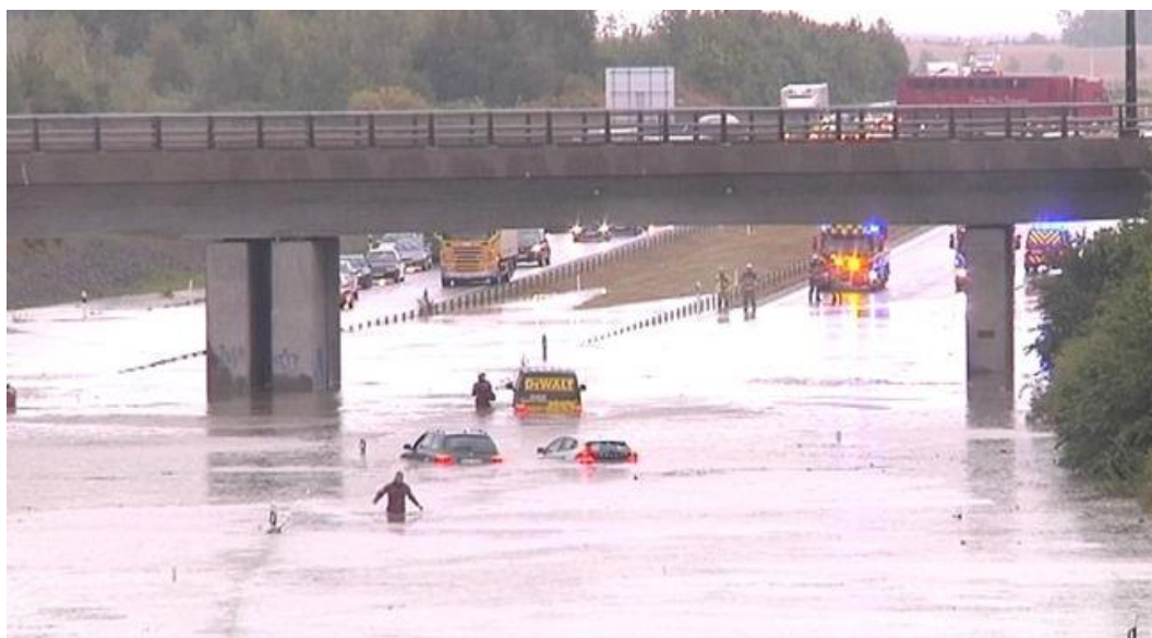
Figur 20 Översvämmad viadukt i Malmö den 31 augusti 2014 ( www.svt.se ).
