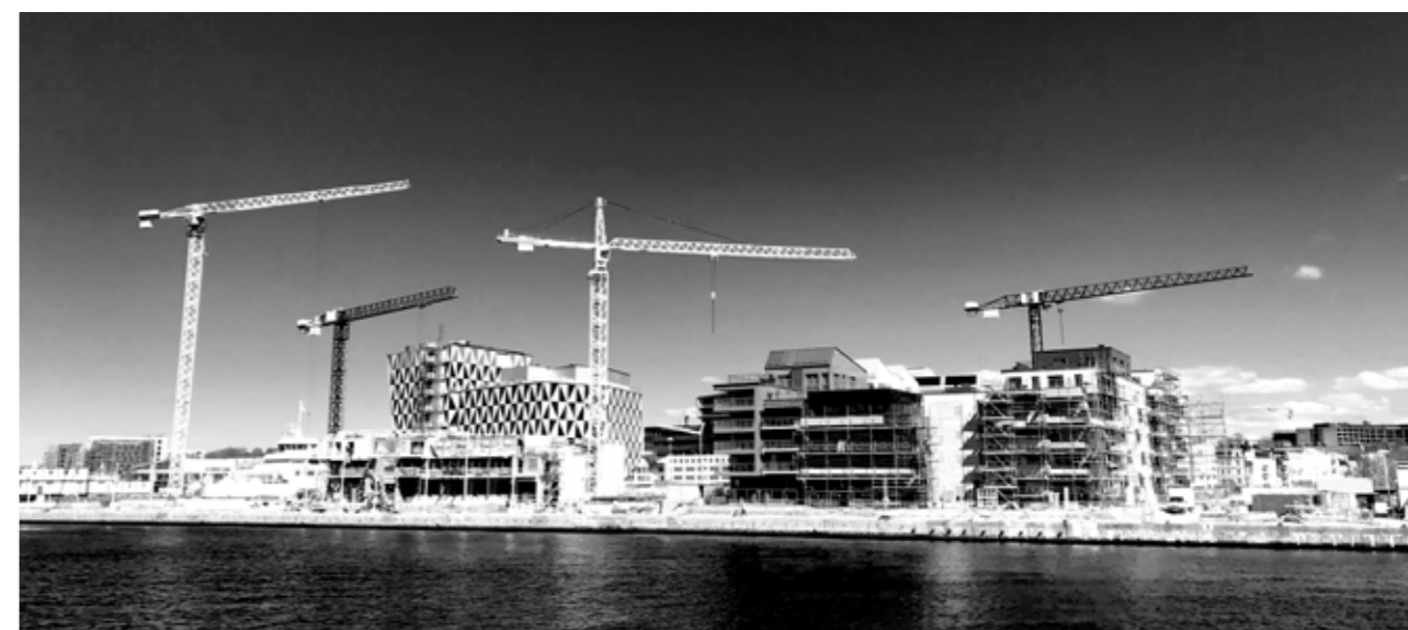
Det byggs för fullt i Helsingborg.
